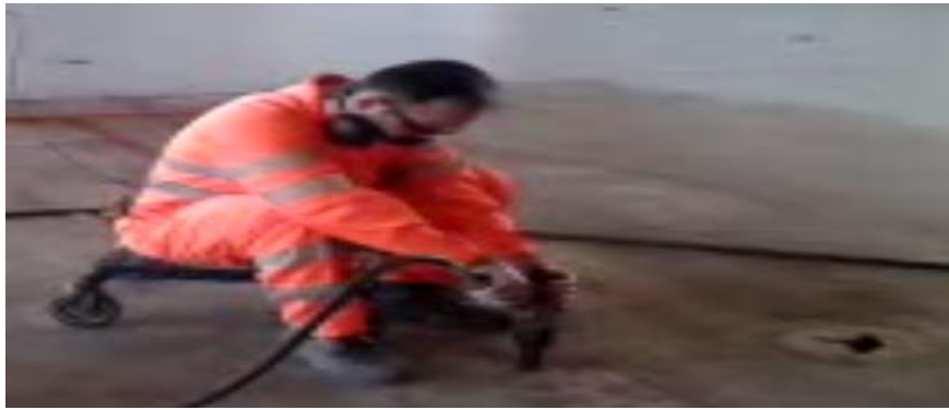
Resim 2.24. Raspa İşlemi Esnasında Tekerlekli Destek Ekipmanı Kullanımı
