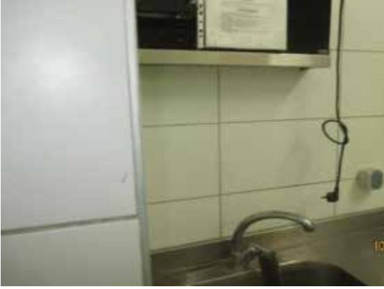
Yemekhanede bulunan seyyar kablolar suyla temas etmesini engelleyecek şekilde havadan geçirilmiştir.
