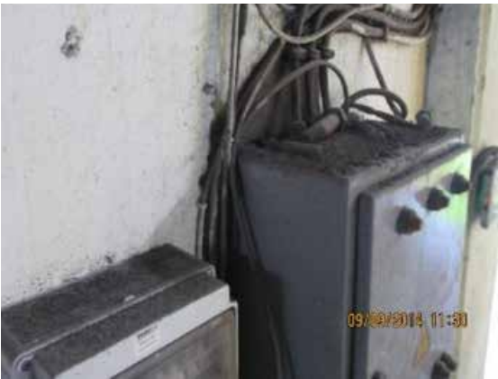
Anod bölümünde bulunan elektrik panosunun kapağı yoktur. Elektrik panosunun kabloları dışarıda ve düzensiz şekilde bulundurulmaktadır. Gerekli düzenlemeler yapılmıştır.
