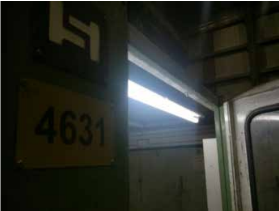
Makine içlerindeki aydınlatmalardan hasarlı olanların düzeltilmiştir. 24V olarak değiştirilmiş yada etanj hale getirilmiştir.
