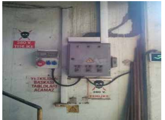
Anod bölümünde bulunan elektrik panosunun kapağı yoktur. Elektrik panosunun kabloları dışarıda ve düzensiz şekilde bulundurulmaktadır. Gerekli düzenlemeler yapılmıştır.
