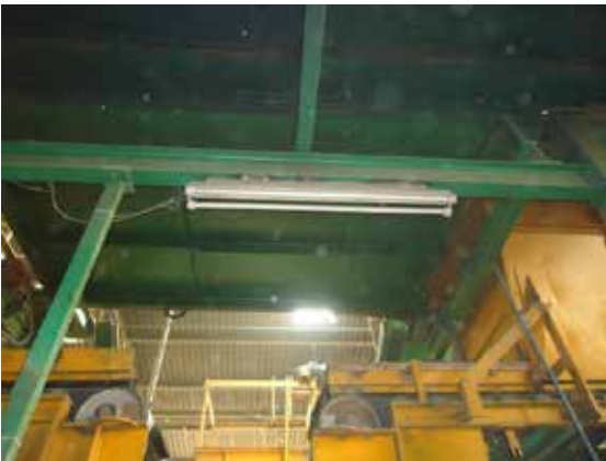
Aydınlatma lambaları etanj hale getirilmiştir.
