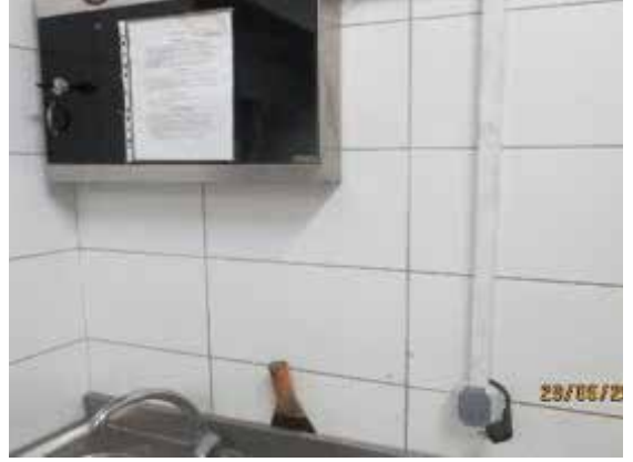
Yemekhanede bulunan seyyar kablolar suyla temas etmesini engelleyecek şekilde havadan geçirilmiştir.
