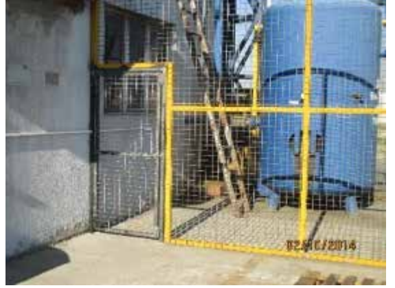
Sürekli döküm sahasında bulunan kompresörün kapısı takılmıştır ve kiletlenmiştir.
