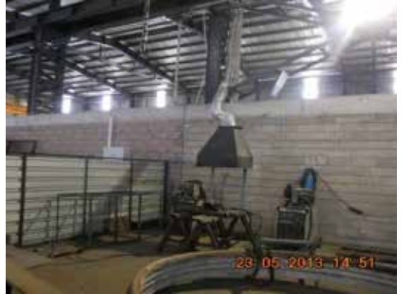
Mekanik atölyede yapılan kaynak esnasında çıkan zararlı gazlarının çalışanlara zarar vermeden ortamdaki uzaklaştırılması için cebri havalandırma yapılmıştır.
