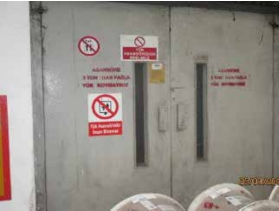
Yük asansörlerinin kabin içinde tuşlar bulunmaktadır, insanların binmesini engellemek amacıyla iptal edilmiştir.
