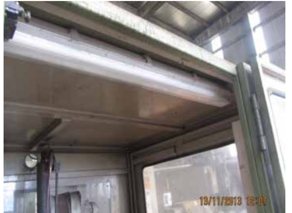
Makine içlerindeki aydınlatmalardan hasarlı olanların düzeltilmiştir. 24V olarak değiştirilmiş yada etanj hale getirilmiştir.
