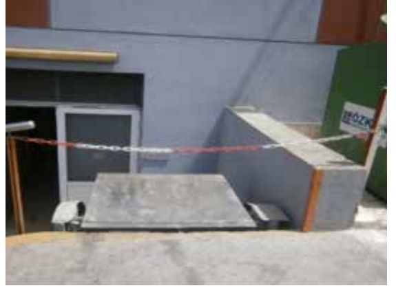
Mutfak girişinde bulunan malzeme asansörünün girişine düşmelere karşı korkuluk yapılmıştır.
