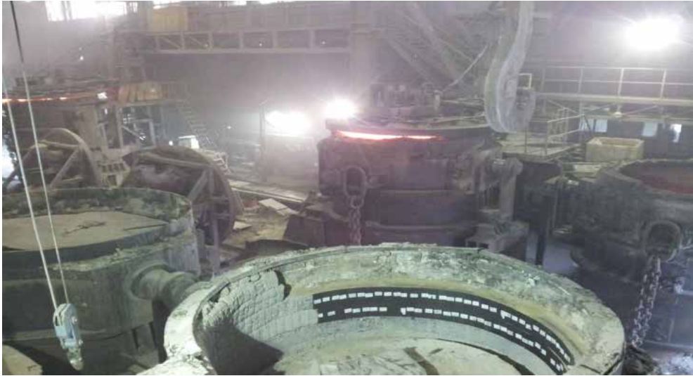
Resim-10 Sıvı Çeliğin İçerisine Konulduğu Potaların Isıtılması ve Tamirati Kalite Kontrol
