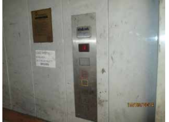
Yük asansörlerinin kabin içinde tuşlar bulunmaktadır, insanların binmesini engellemek amacıyla iptal edilmiştir.
