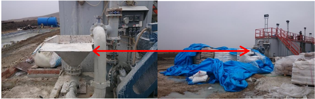
Resim 4.8. Çamur tankına kimyasalların boşaltıldığı alan ve hopper tankı
