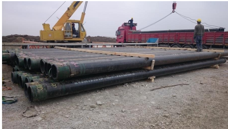
Resim 4.21. Tijler ve kaymasını nleyici aparatlar
